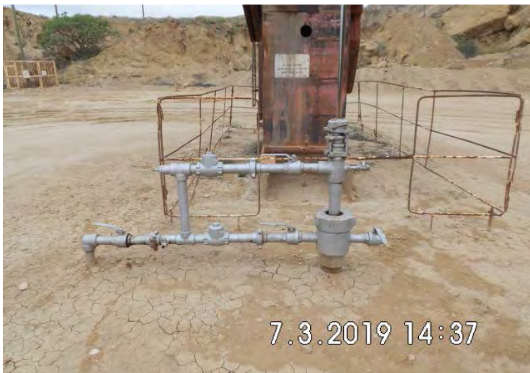
Fotografía 1. Pozo EA11178D (Coordenadas WGS84-zona 17S: 473270mE, 9527093mN), pozo productivo tipo BM. Vista desde cerca del pozo. Sin indicio de derrame de hidrocarburos ni alteración de suelo.
