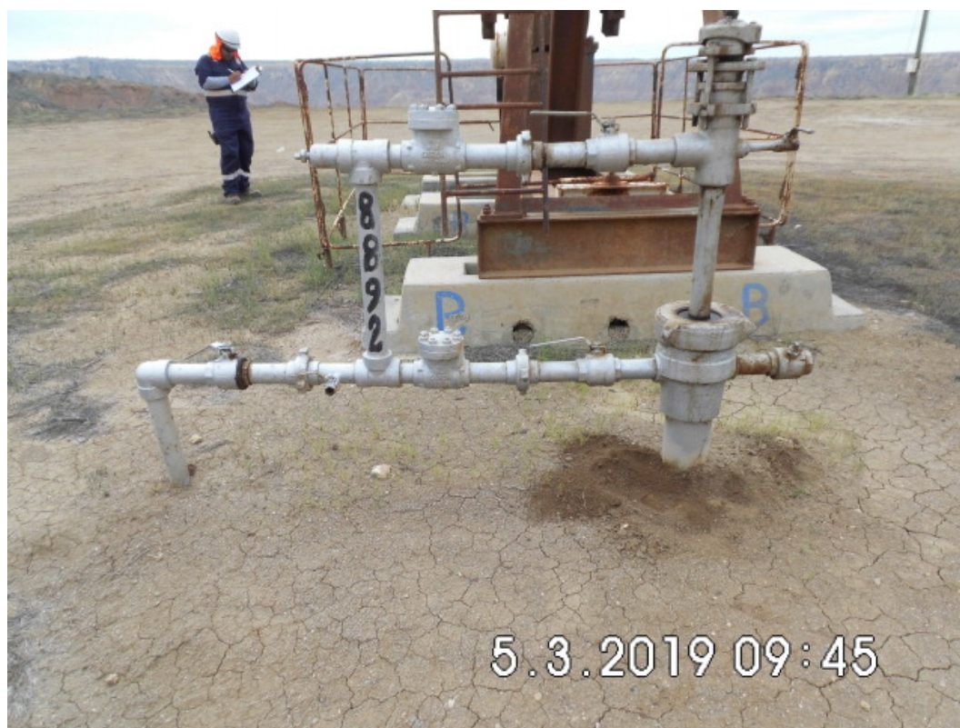
Fotografía 1. Pozo EA8892 (Coordenadas WGS84-zona 17S: 473435mE, 9524302mN), pozo productor tipo BM. Vista desde cerca del pozo. Con indicio de derrame de hidrocarburos y alteración de suelo alrededor del cabezal de pozo con un área de aproximadamente 0.5 m 2 .
