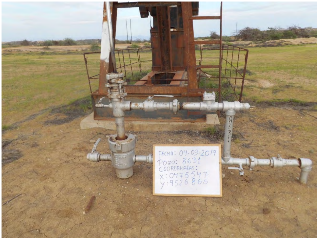
Fotografía 1. Pozo AA8631D (Coordenadas WGS84-zona 17S: 475547mE, 9526865mN), pozo productor tipo BM. Vista de cerca del pozo.
