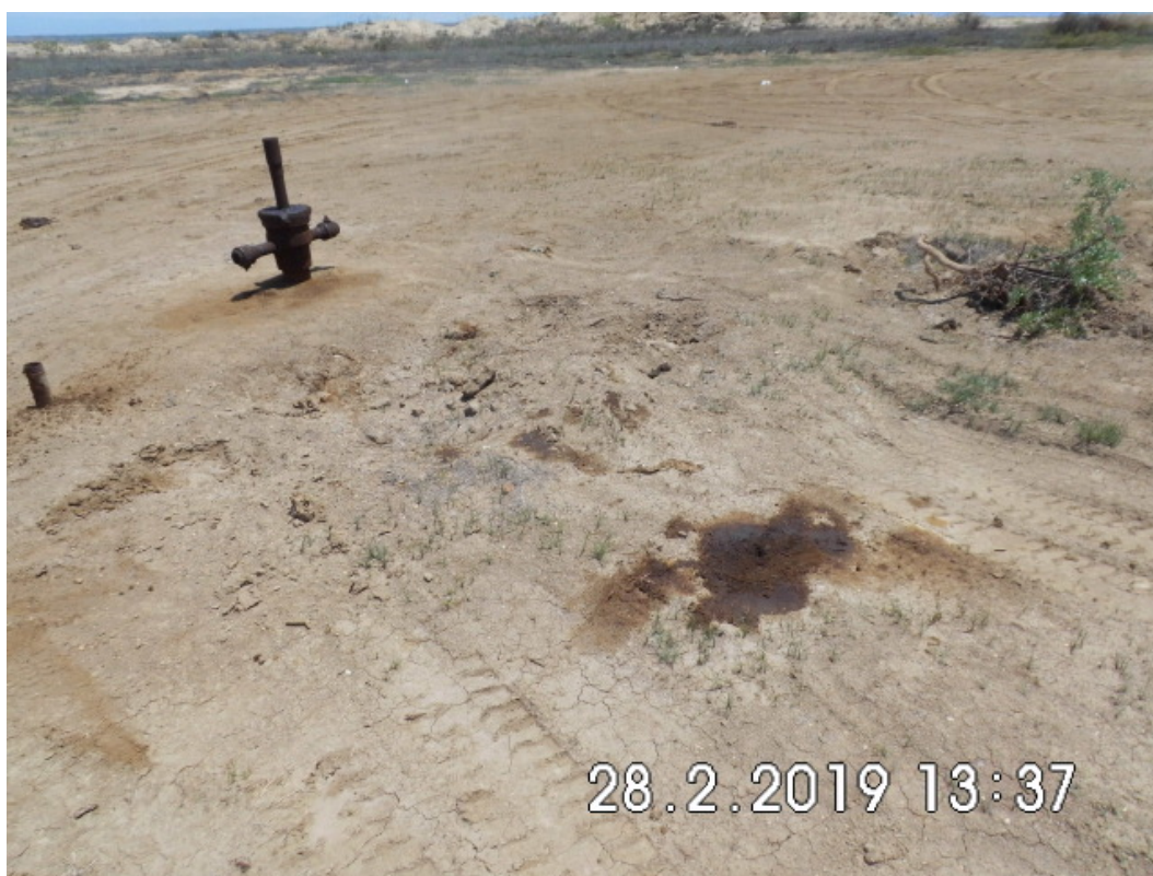
Fotografía 1. Pozo EA8288 (Coordenadas WGS84-zona 17S: 472838mE, 9523946mN), pozo productor tipo ACTPETS. Vista desde cerca del pozo. Con indicio de derrame de hidrocarburos y alteración de suelo alrededor del cabezal de pozo con un área de aproximadamente 5.5 m 2 .
