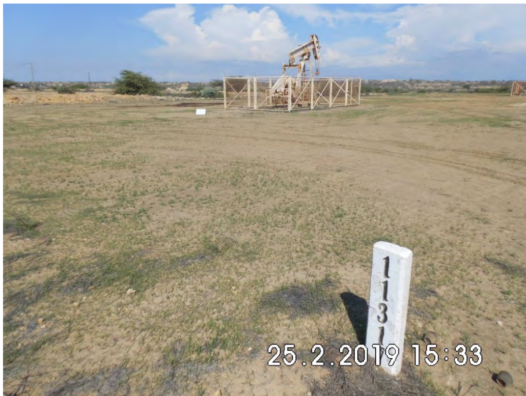
Fotografía 2. Pozo EA11317D vista panorámica de la plataforma. Se observa el suelo impregnado por hidrocarburos cerca al pozo.
