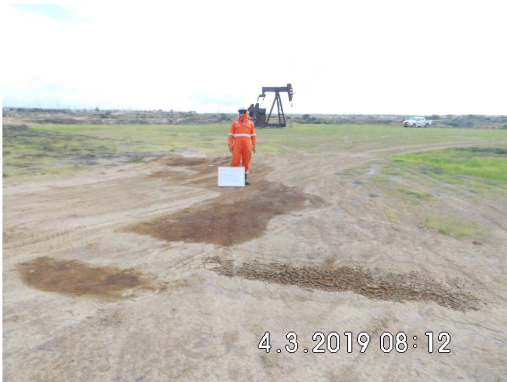
Fotografía 2. Pozo EA8631D vista panorámica de la plataforma. Se observa el suelo impregnado por hidrocarburos a metros del pozo.
