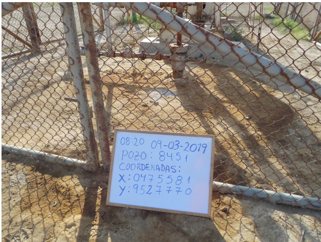
Fotografía 1. Pozo EA8451 (Coordenadas WGS84-zona 17S: 475581mE, 9527770mN), pozo productor tipo BM. Vista desde cerca del pozo. Con indicio de derrame de hidrocarburos y alteración de suelo alrededor del cabezal de pozo con un área de aproximadamente 2 m 2 .
