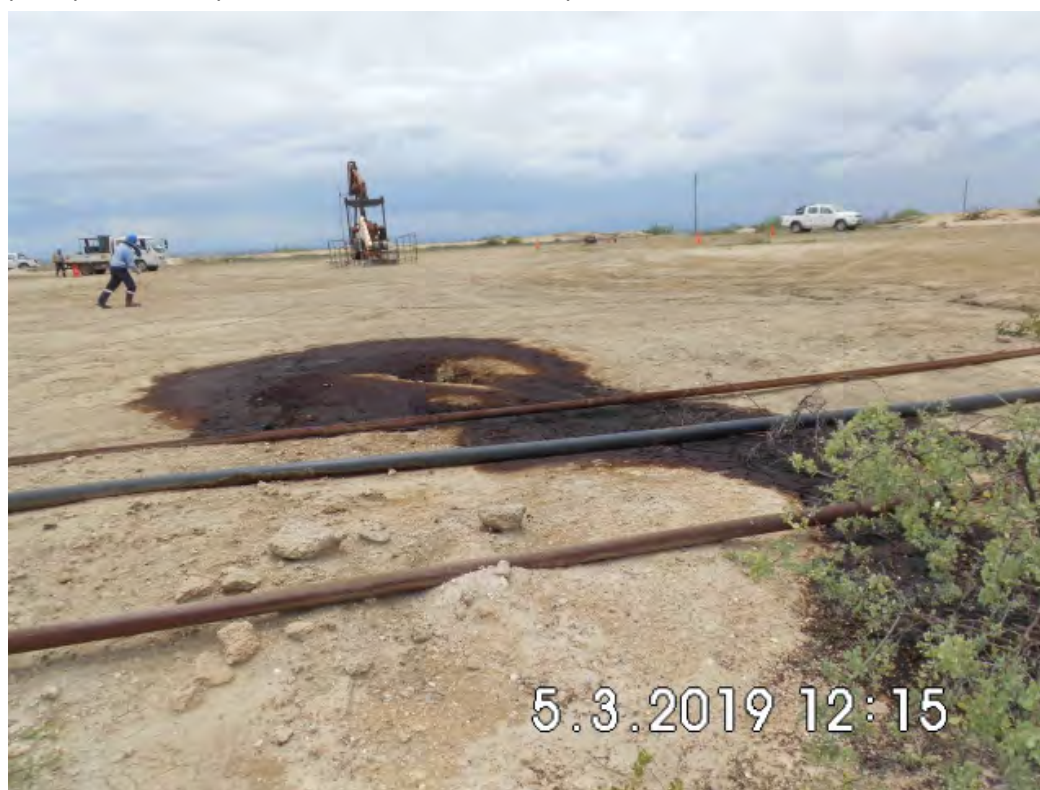
Fotografía 2. Pozo EA8528 la mancha del derrame de hidrocarburos y alteración de suelo alrededor de su ducto próximo al pozo. El área afectada de aproximadamente 40 m 2 .
