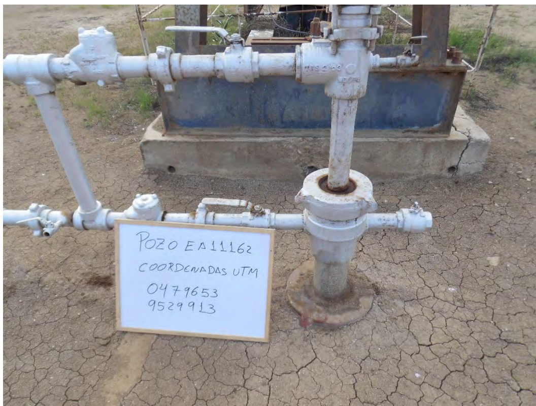
Fotografía 1. Pozo EA11162 (Coordenadas WGS84-zona 17S: 479653mE, 9529913mN), pozo productor tipo BM. Vista desde cerca del pozo. Sin indicio de derrame de hidrocarburos ni alteración de suelo.
