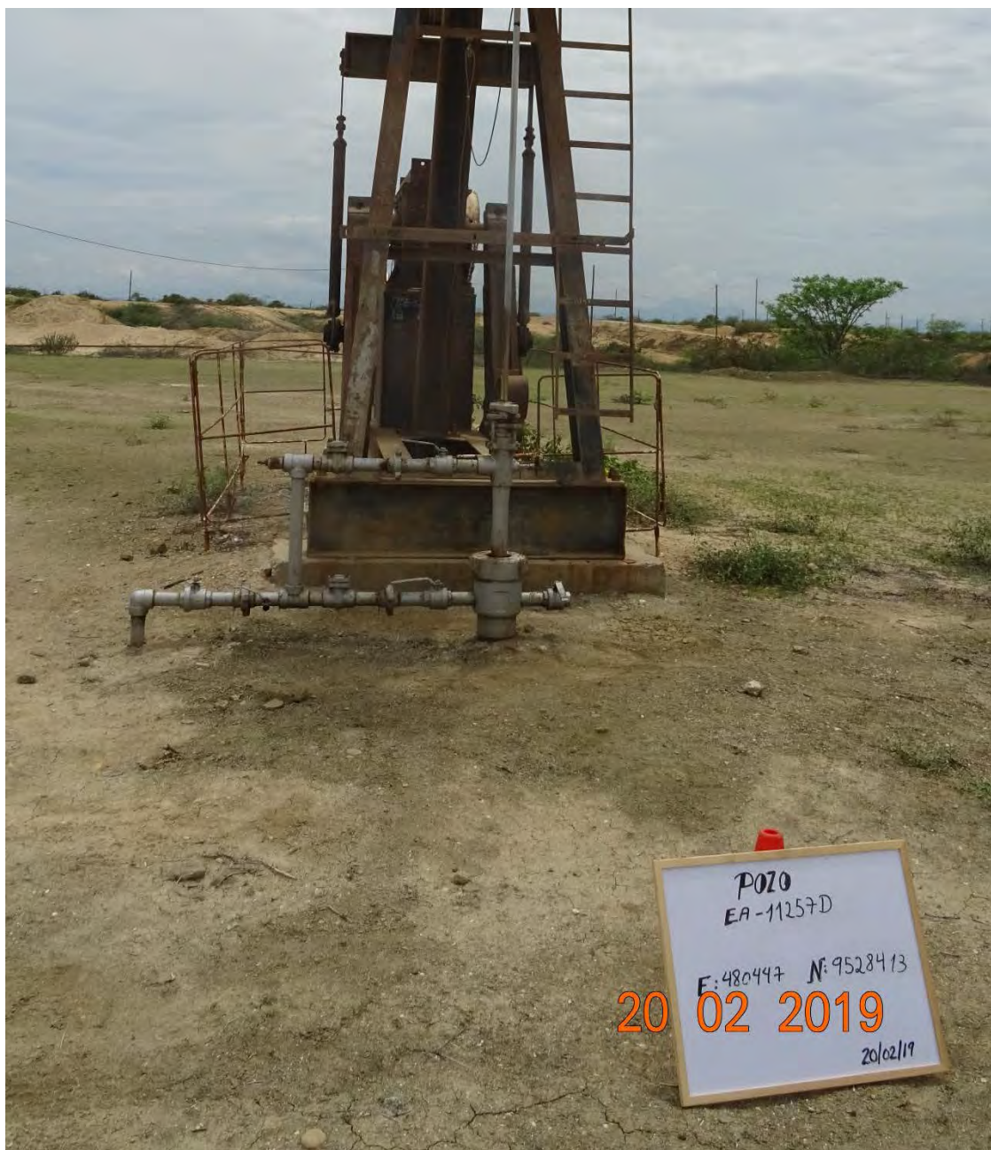
Fotografía 1. Pozo EA11257D (Coordenadas WGS84-zona 17S: 480447mE, 9528413mN), pozo productivo tipo BM. Vista desde cerca del pozo. Sin indicio de derrame de hidrocarburos ni alteración de suelo.
