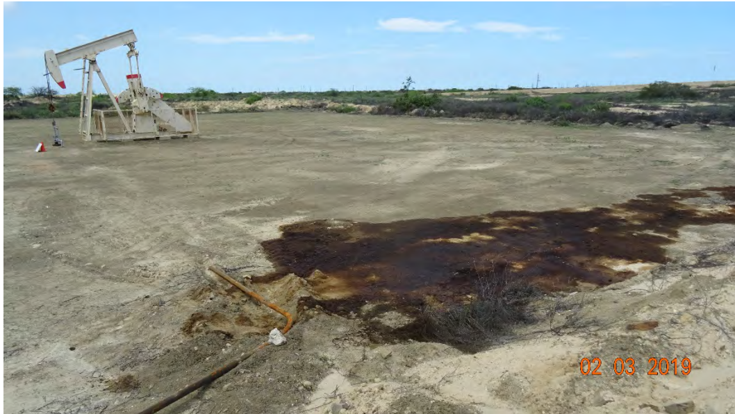
Fotografía 1. Pozo EA11244D (Coordenadas WGS84-zona 17S: 480458 mE, 9529430 mN), pozo productivo tipo BM. Vista desde cerca del cabezal del pozo. Con indicio de derrame de hidrocarburos y alteración de suelo en área muy próximo al pozo.
