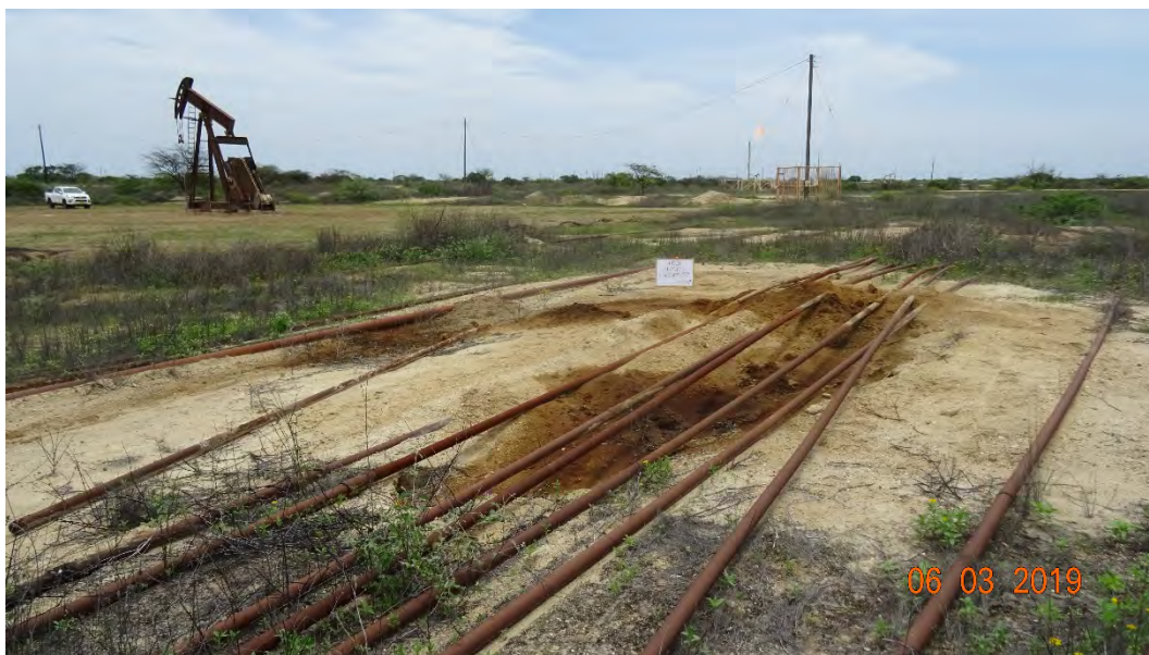
Fotografía 2. Pozo EA8604 la mancha del derrame de hidrocarburos y alteración de suelo alrededor de su ducto próximo al pozo. El área afectada de aproximadamente 10 m 2 .
