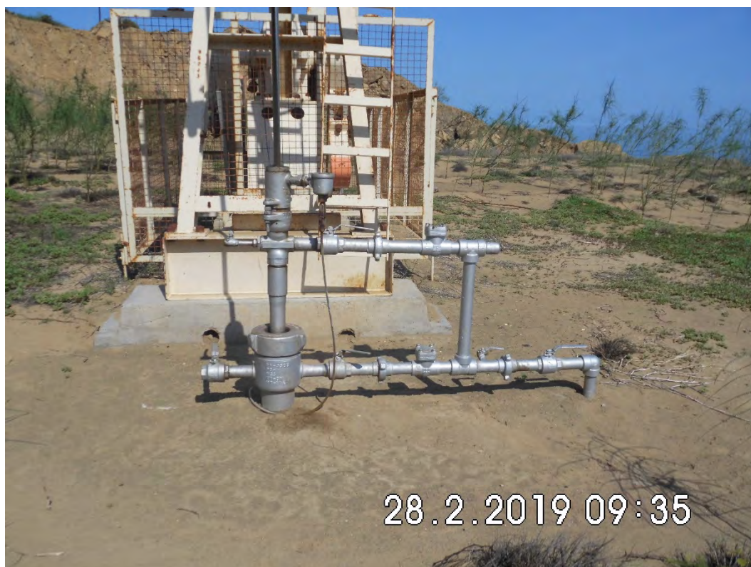
Fotografía 1. Pozo EA11318D (Coordenadas WGS84-zona 17S: 474641mE, 9528998mN), pozo productor tipo BM. Sin indicio de derrame de hidrocarburos ni alteración de suelo.
