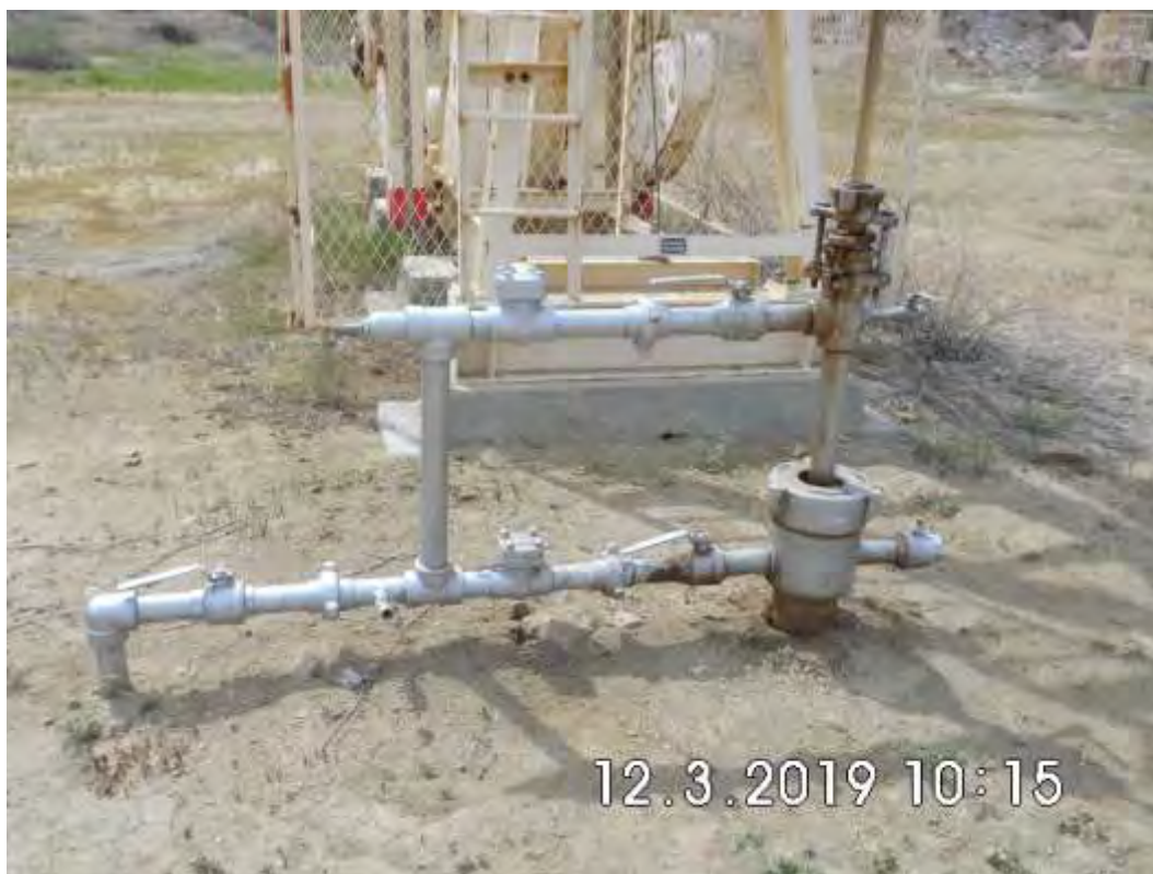
Fotografía 1. Pozo EA11166 (Coordenadas WGS84-zona 17S: 481788mE, 9533277mN), pozo productor tipo BM. Vista desde cerca del pozo. Sin indicio de derrame de hidrocarburos y alteración de suelo.
