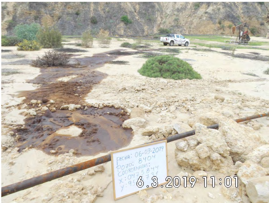
Fotografía 2. Pozo EA8404 la mancha del derrame de hidrocarburos y alteración de suelo alrededor de su ducto muy próximo al pozo.
