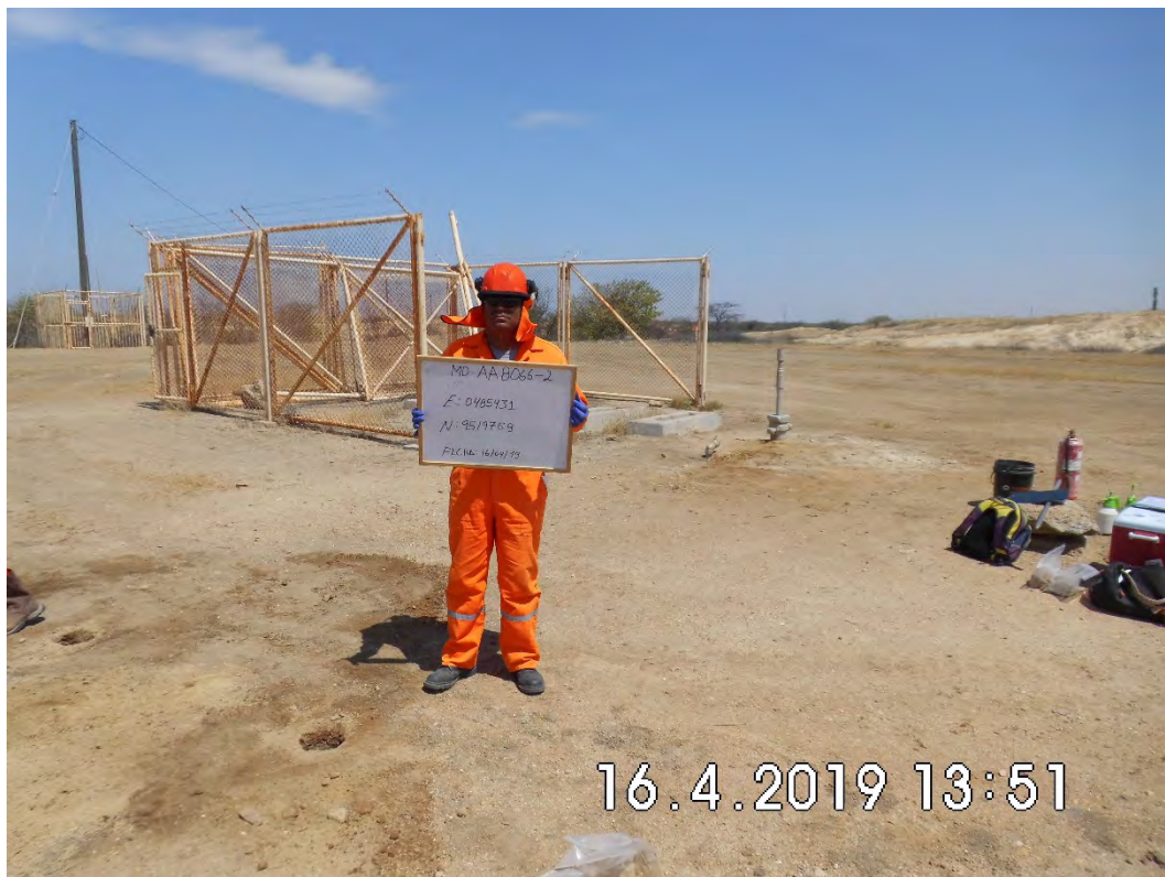
Fotografía 4. Pozo AA8066. Muestreo de Detalle (MD-AA8066-2). Se muestreo con intervalo de profundidad de 0.25cm. La profundidad máxima alcanzada fue de 1 metro.
