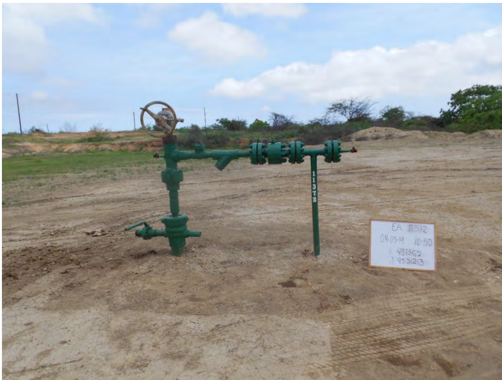
Fotografía 1. Pozo EA11372 (Coordenadas WGS84-zona 17S: 487562 mE, 9531213 mN), pozo inyector tipo ACTINYA. Vista desde cerca del cabezal del pozo. Sin indicio de derrame de hidrocarburos ni alteración de suelo.
