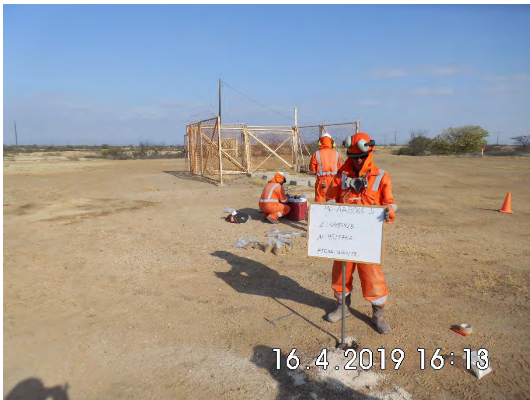
Fotografía 7. Pozo AA8066. Muestreo de Detalle (MD-AA8066-5). Los intervalos de muestreo fueron de 0.00-0.50 metros y 0.50-1.00 metros.
