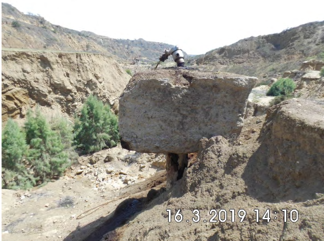
Fotografía 2. Pozo EA11022 vista panorámica de la plataforma. Se observa el suelo impregnado por hidrocarburos alrededor del pozo.
