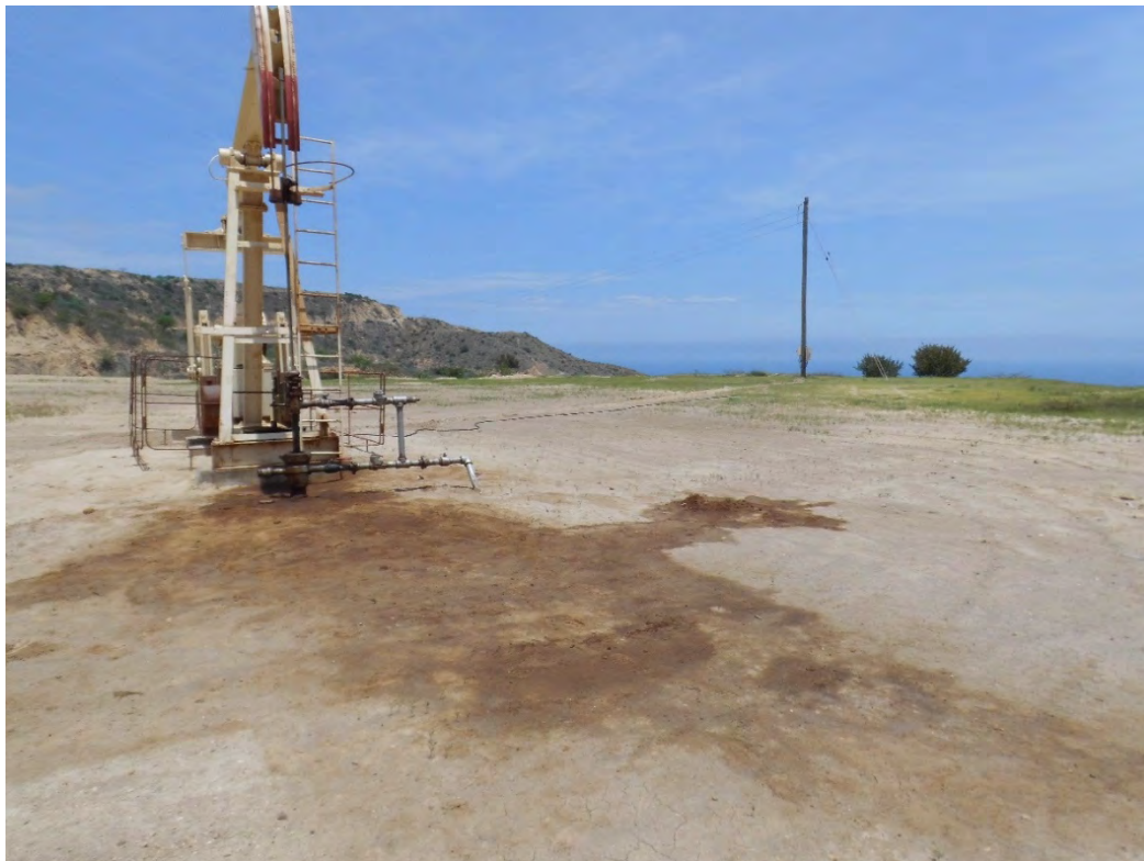
Fotografía 2. Pozo EA8333 vista panorámica de la plataforma. Se observa el suelo impregnado por hidrocarburos cerca al pozo.
