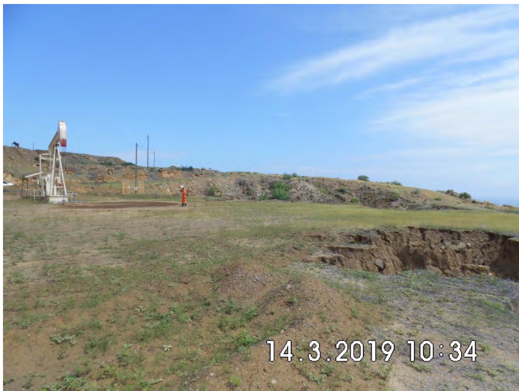
Fotografía 2. Pozo EA8524 vista panorámica de la plataforma. Se observa el suelo impregnado por hidrocarburos cerca al pozo.
