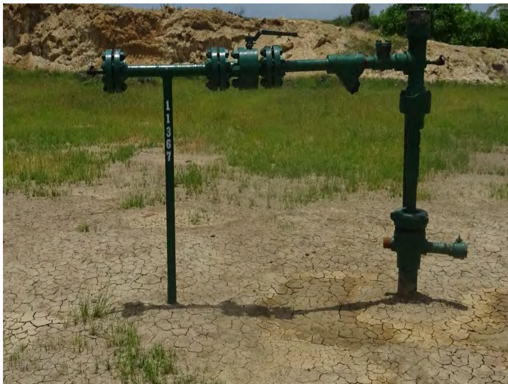
Fotografía 1. Pozo EA11367 (Coordenadas WGS84-zona 17S: 484758mE, 9530196mN), pozo inyector tipo ACTINYA. Vista desde cerca del pozo. Sin indicio de derrame de hidrocarburos ni alteración de suelo.
