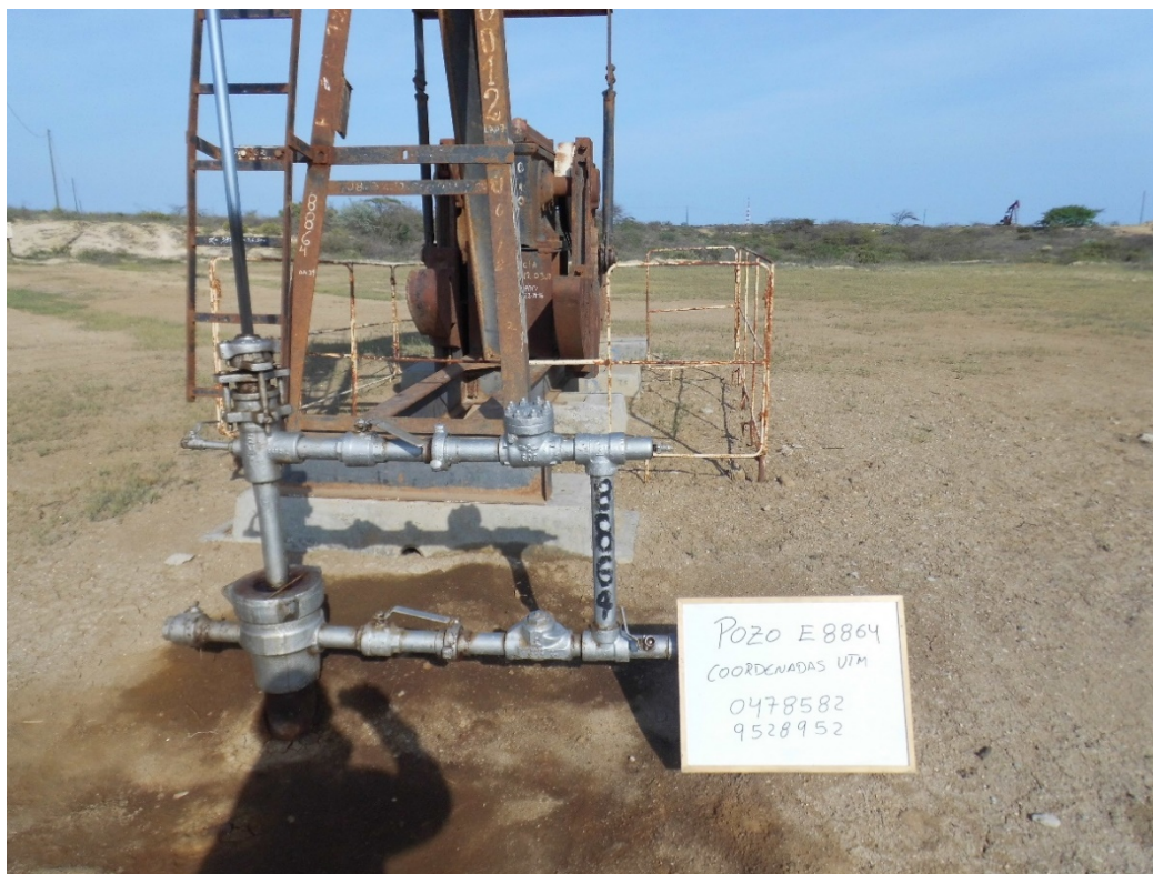
Fotografía 1. Pozo EA8864 (Coordenadas WGS84-zona 17S: 478582mE, 9528952mN), pozo productor tipo BM. Vista desde cerca del pozo. Con indicio de derrame de hidrocarburos y alteración de suelo alrededor del cabezal de pozo con un área de aproximadamente 2 m 2 .
