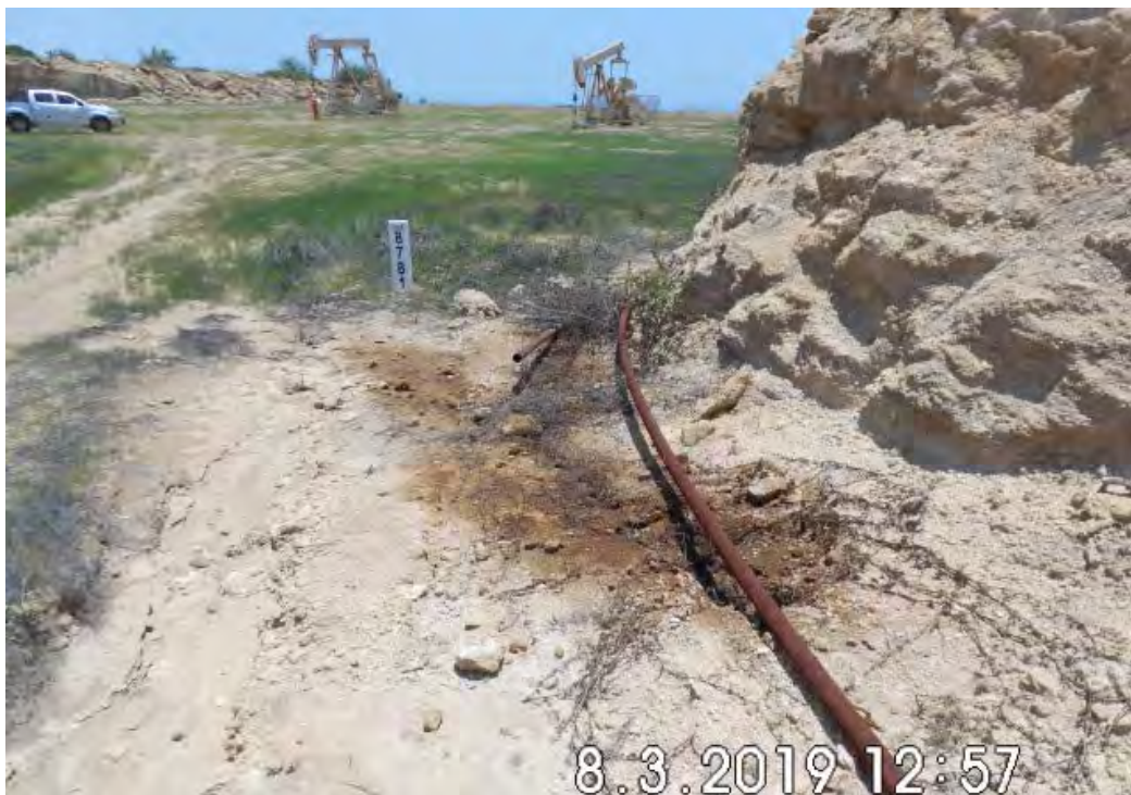
Fotografía 2. Pozo EA8781 la mancha del derrame de hidrocarburos y alteración de suelo alrededor de su ducto muy próximo al pozo.
