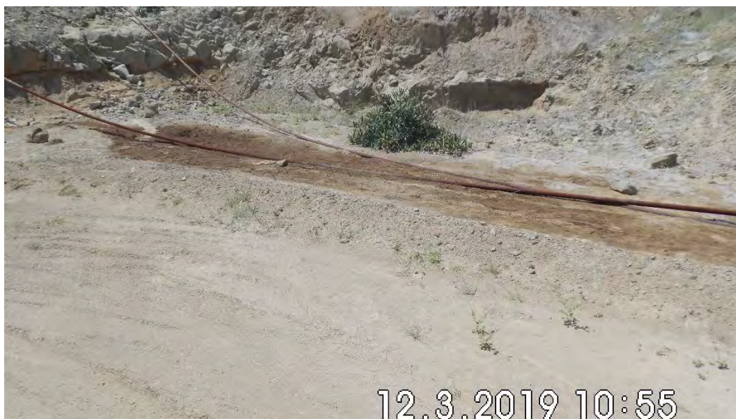
Fotografía 2. Plataforma EA1127 – indicio de derrame de hidrocarburos a lo largo de la línea de conducción ubicada próxima al pozo.
