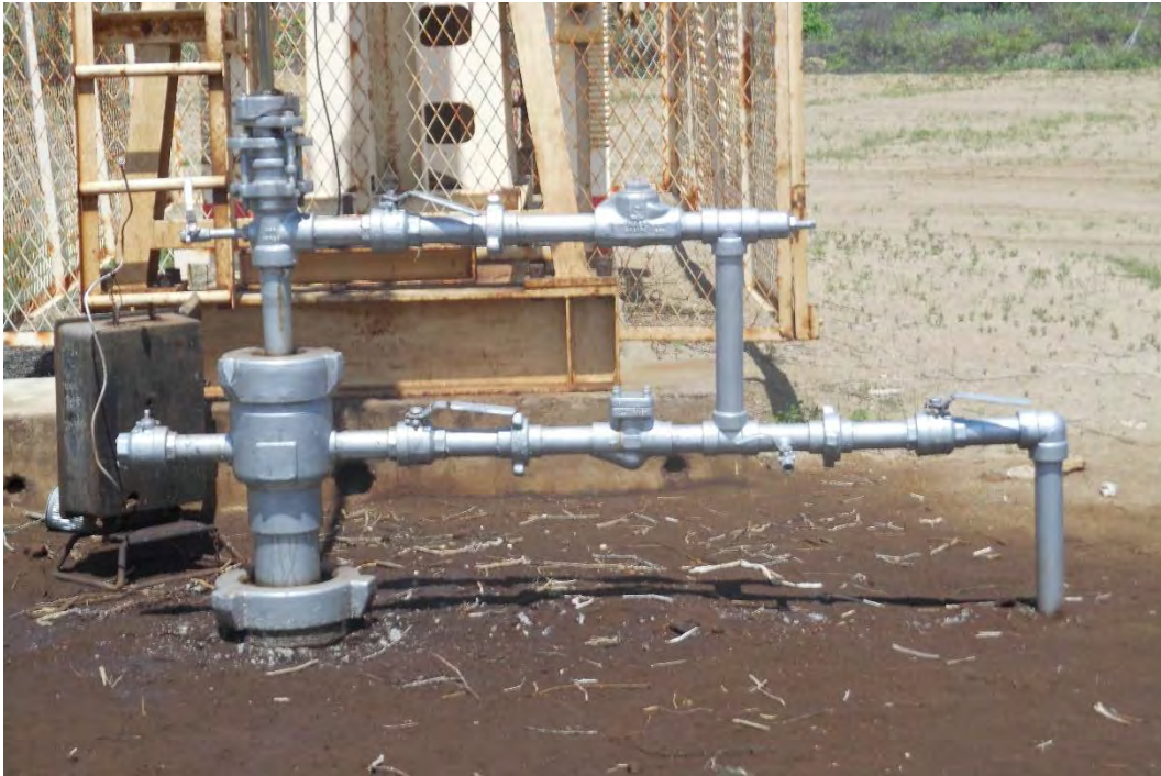
Fotografía 1. Pozo EA8926 (Coordenadas WGS84-zona 17S: 482326mE, 9528416mN), pozo productor tipo BM. Vista desde cerca del pozo. Con indicio de derrame de hidrocarburos, se observa la alteración de suelo.
