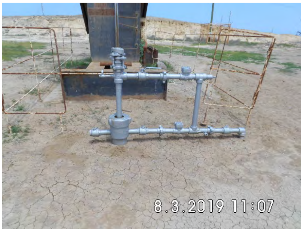
Fotografía 1. Pozo EA11326D (Coordenadas WGS84-zona 17S: 473265mE, 9526263mN), pozo productor tipo BM. Vista desde cerca del pozo. Sin indicio de derrame de hidrocarburos ni alteración de suelo.
